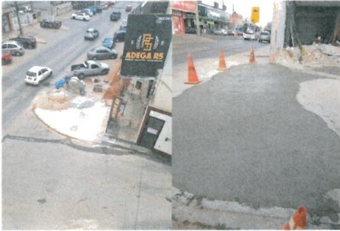
Construção de Calçadas na Rua 3.
