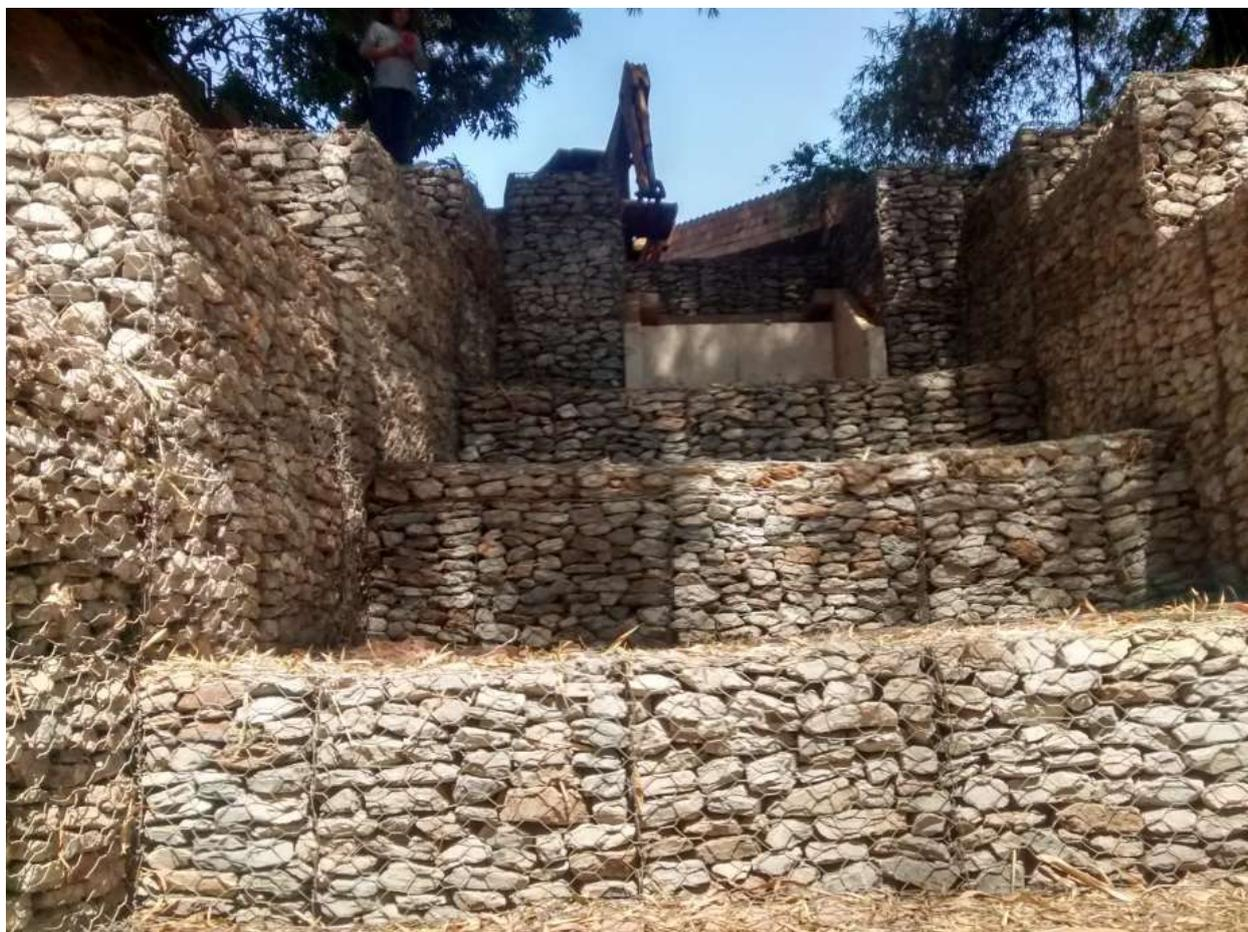
Figura 09 - Escada em gabião dissipador da Rede nº 56A
