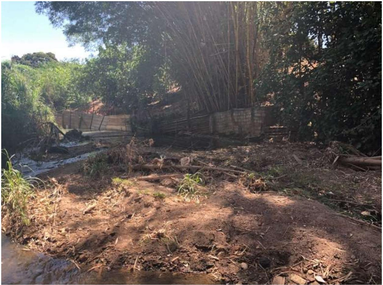
Figura 10 - Grande acúmulo de sedimentos no leito do córrego Samambaia, na altura do lançamento da Rede n.º 56A. Na porção ao fundo da figura, há escoramento rudimentar do talude, provavelmente feito por moradores na intenção de
