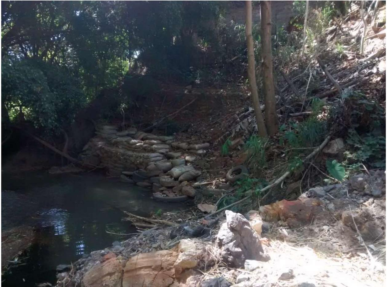
Figura 08 - Vista lateral da contenção em *rip rap* margem Córrego Samambaia, à jusante do Lançamento rede nº 56
