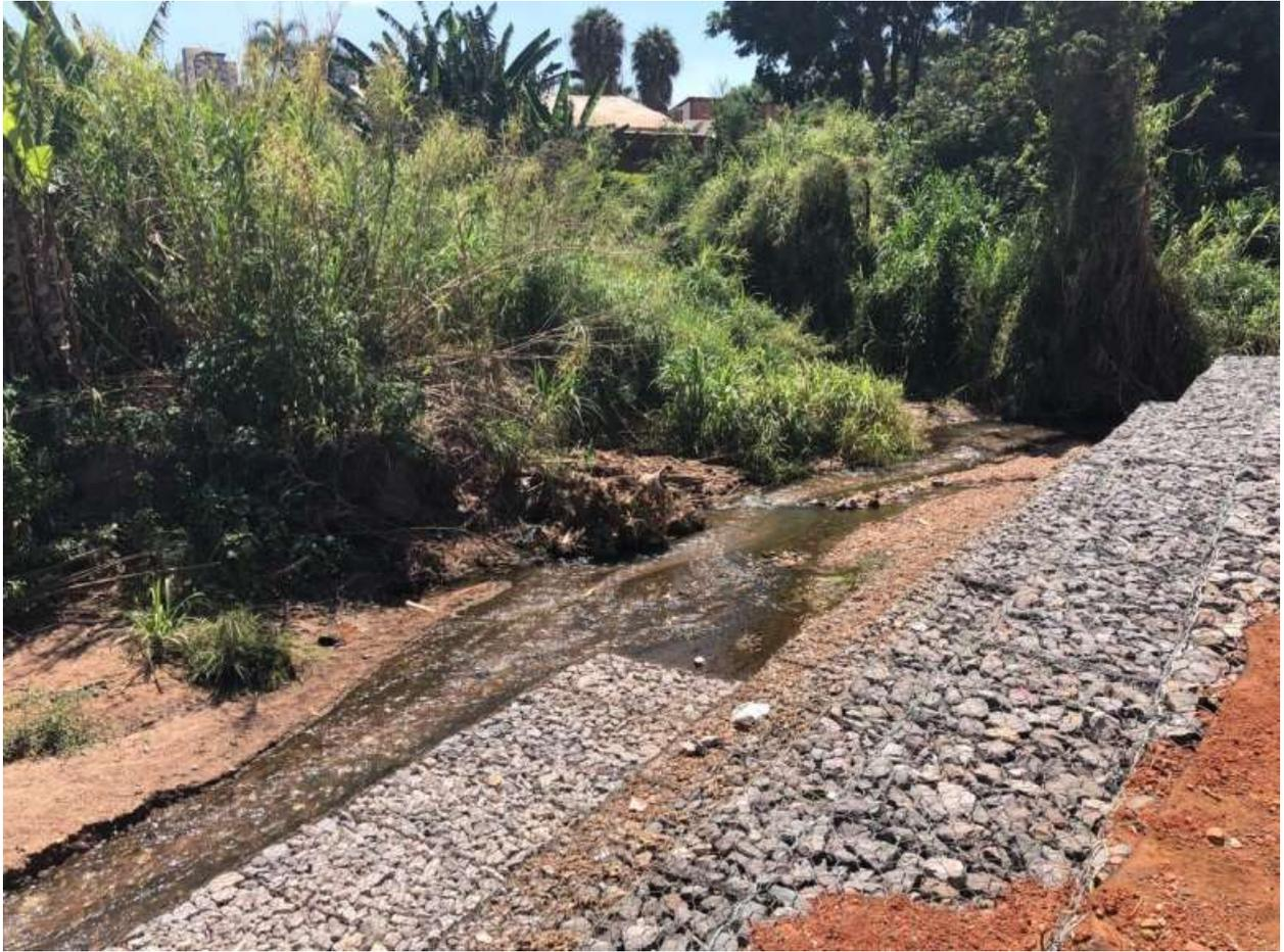
Figura 13 - Vista do coxão Reno, já alongado. Início do muro em gabião
