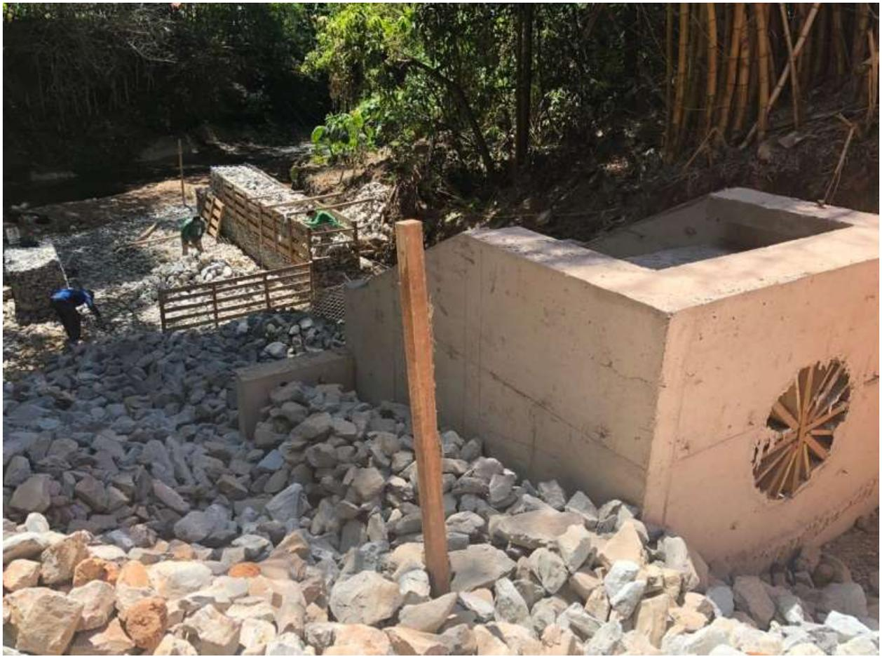
Figura 11 - Operário da empresa CONTERC trabalhando na construção da escada em gabião do lançamento Rede nº 56B
