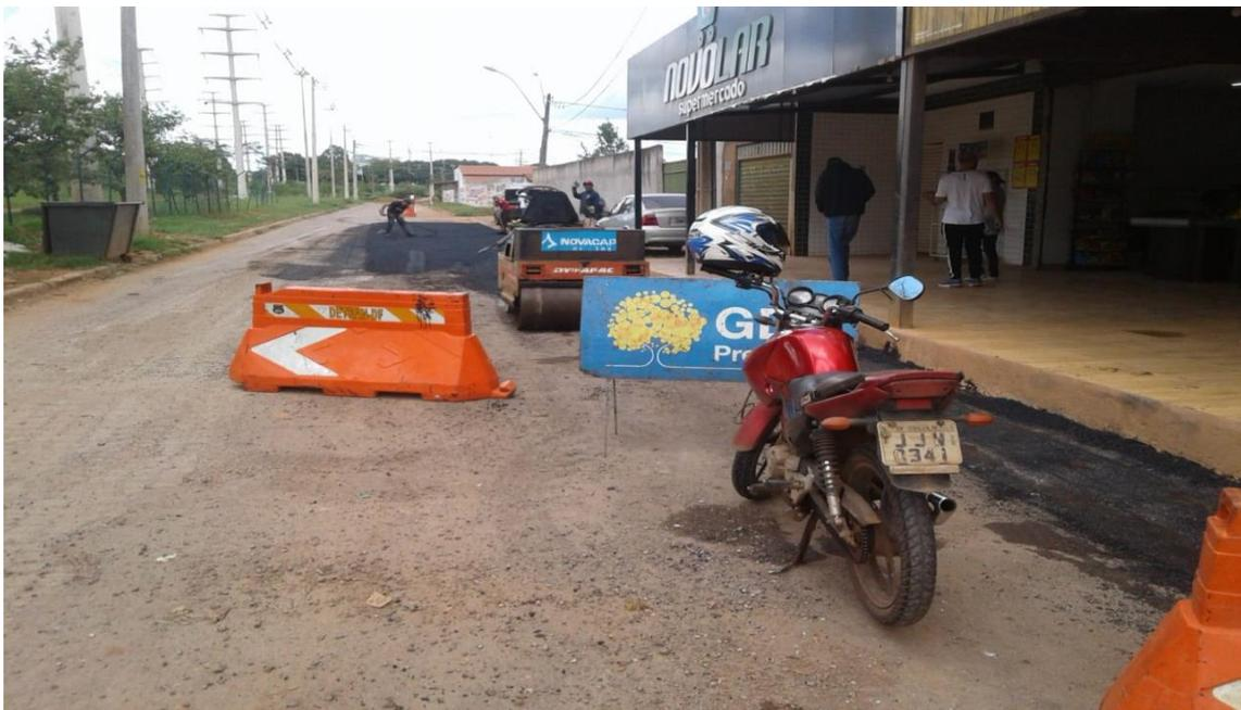
**Descrição:** Operação Tapa Buraco realizada na altura da CH. 186.
