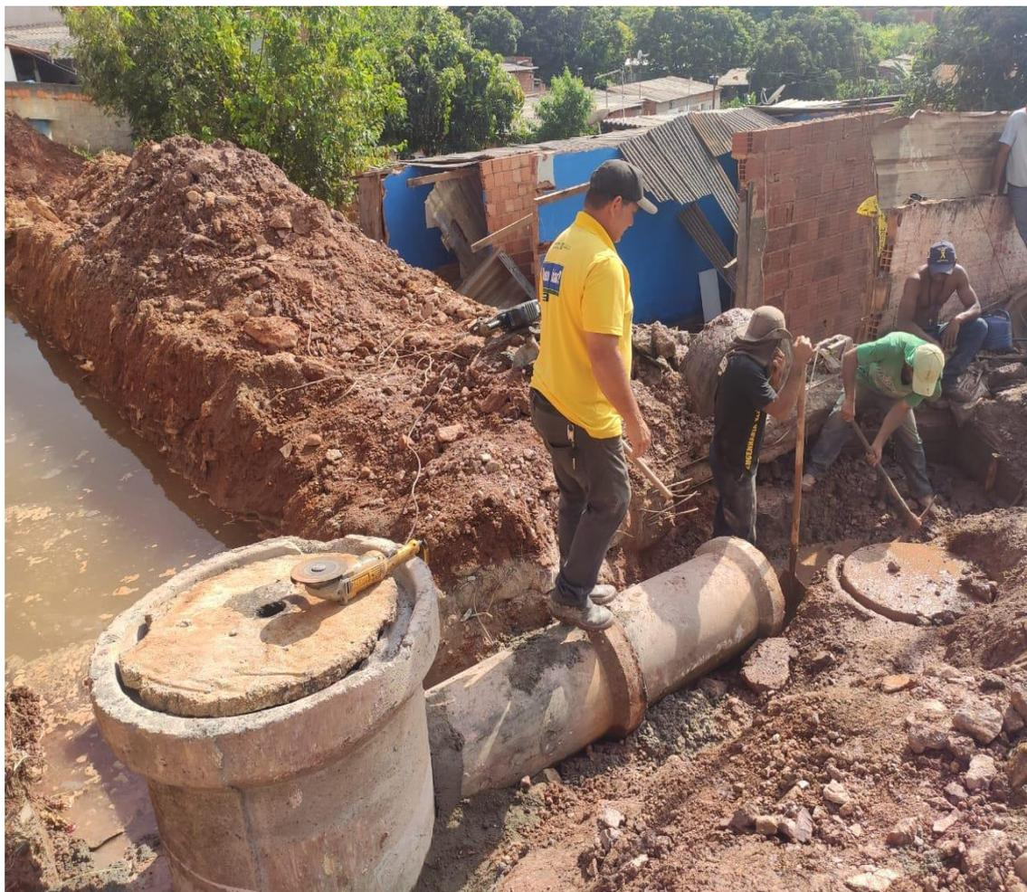
**Descrição:** Instalação de Rede de Águas Pluviais na Rua 19.
