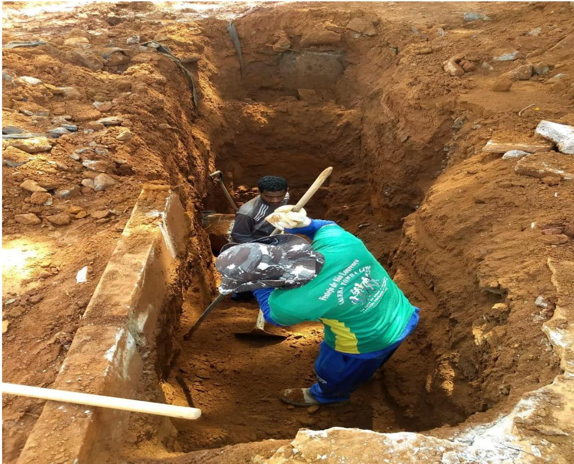
**Descrição:** Empresa Basevi fazendo a abertura de Três Bocas de Lobo dos dois lados da Rua 8 para coletar a água da Chuva.
