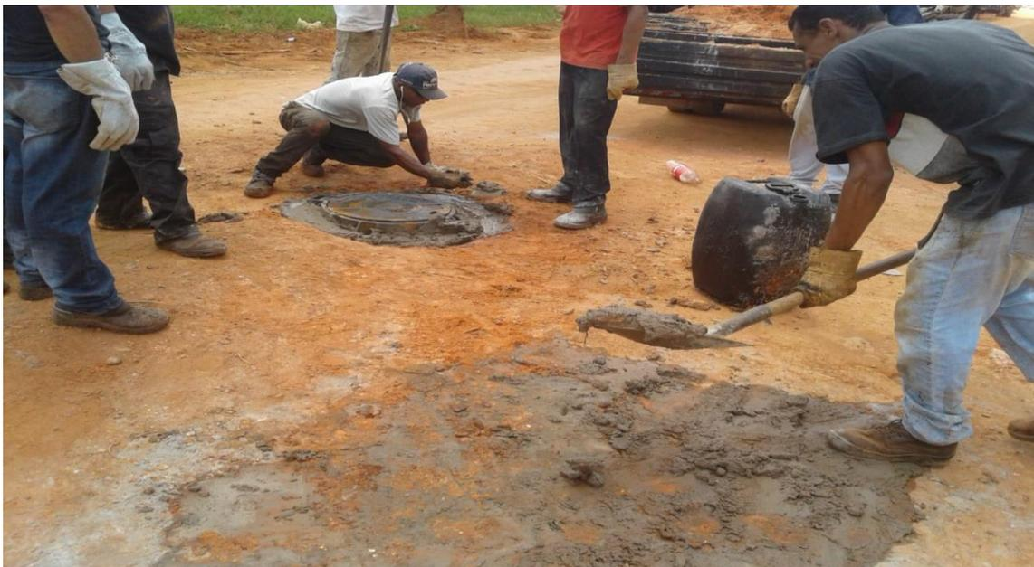
**Descrição:** Instalação de Tampa de Ferro em esgoto na Rua 3.
